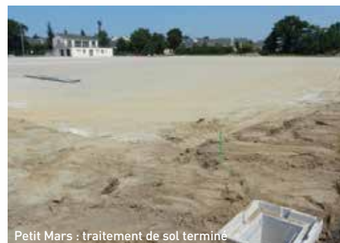
Petit Mars : traitement de sol terminé
