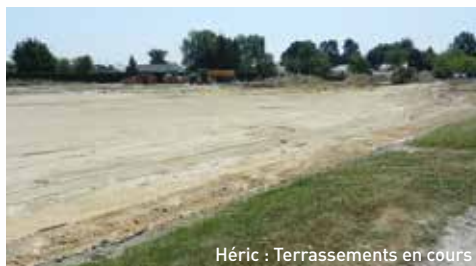
Héric : Terrassements en cours
